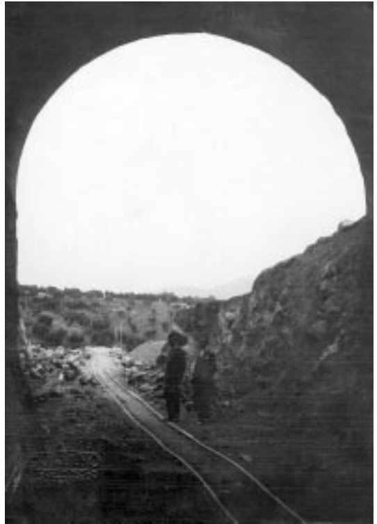
TÚNEL DE LA LÍNEA FÉRREA JEREZ-ALMARGEN EN LAS PROXIMIDADES DE PUERTO SERRANO (FOTO: QUIJANO).
