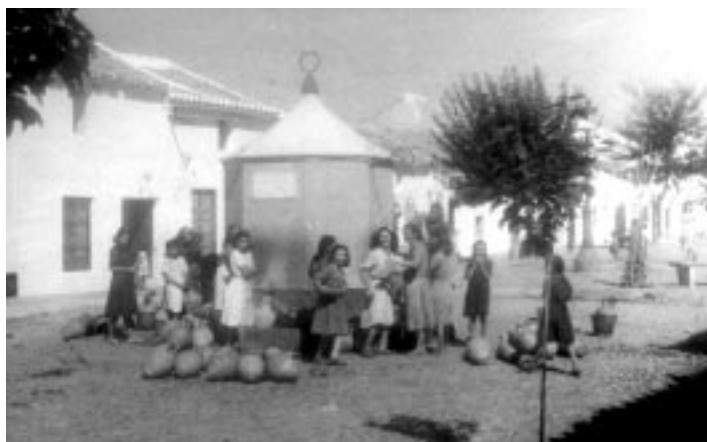
LA FUENTE DE LA CALLE RONDA, LLAMADA “FUENTE DE LA ZARZA”, FUE CONSTRUIDA EN 1922-23, SIENDO ALCALDE PEDRO GARCÍA VÁZQUEZ.
