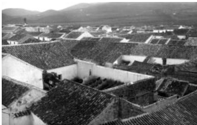
TEJADOS DE PUERTO SERRANO DESDE LA TORRE DE LA PARROQUIA.
